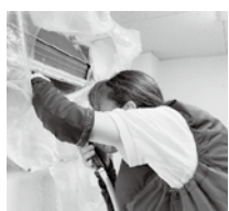
エアコンクリーニング
